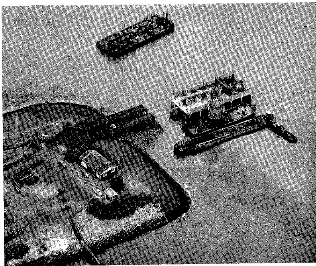
Aansluiting van de eerste caisson op het landhoofd
